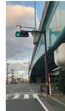
能登半島地震での 北陸道の免震橋
