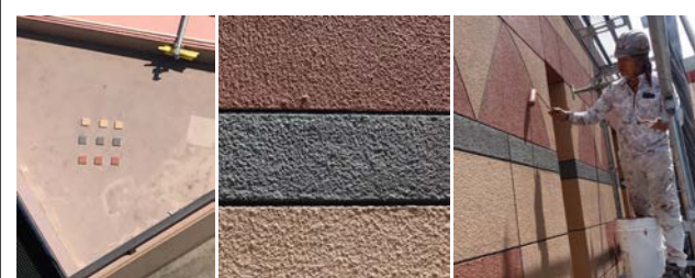
三州瓦微粉末塗料を使った暴露試験と試験施工@三河安城市
