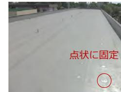
機械的固定工法防水システム
